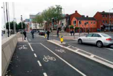
Zone de stockage : les cyclistes qui patientent pour tourner à droite ne gênent pas le passage de ceux qui poursuivent tout droit.
